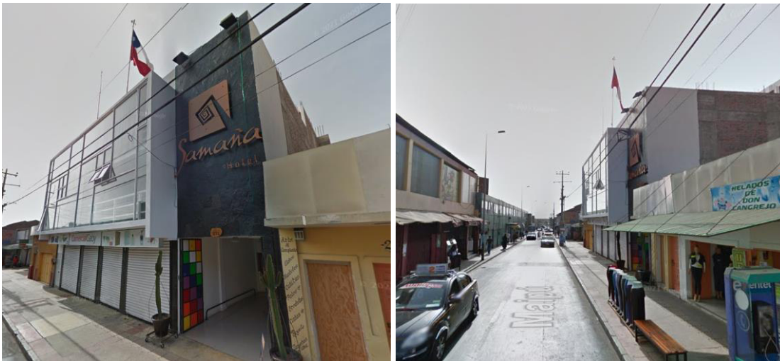
Fig. 3 y 4: Fachada del Edificio, emplazado en calle Maipú de gran circulación de transporte colectivo. Es un edificio moderno construido en el 2011, que tuvo destino de Hotel. Cabe señalar que, tal como se ve en la imagen, el acceso al edificio funciona como calzo de estacionamiento del edificio, por lo que de todas maneras se debería arrendar un calzo en el área circundante.
