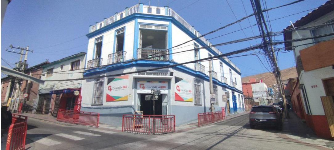
Fig. 3: Fachada de Alternativa 2 (edificio color blanco). Edificio emplazado en la esquina de calle Colón y Sotomayor. Se observa la tipología antigua de la edificación, y la gran altura de sus pisos. Cabe señalar que el edificio se divide en 3 partes con accesos independientes (uno por la esquina, y dos accesos por calle Colón)
