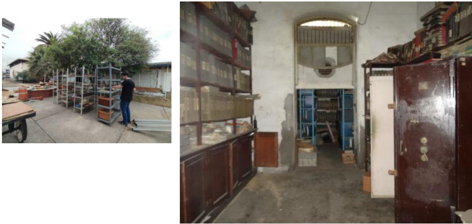
Fig. 8: Imágenes de los Archivos dañados con la filtración, y su almacenaje provisorio.
